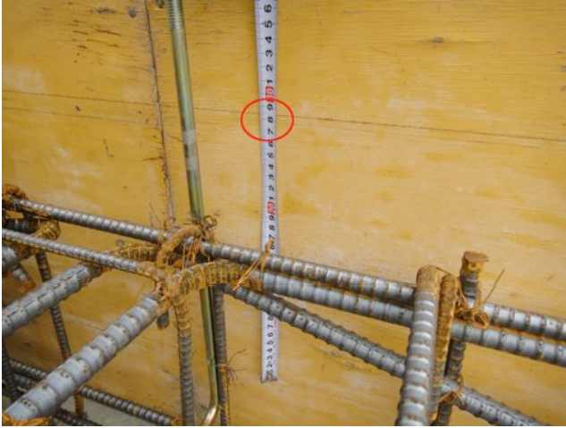
【アンカーボルトの確認】完了後の確認 アンカーボルト(M12、M16)の設置状態を確認しました。問題ありませんでした。(M12埋め込み250mm以上、M16埋め込み360mm以上)
